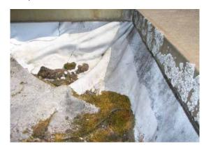
Abspannung durch Alterung Verflüchtigung des Weichmachers
