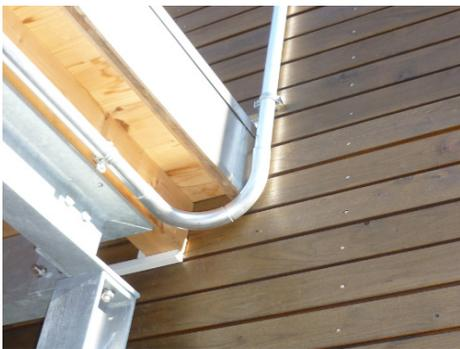
DC-Leitung auf brennbarer Holzfassade in nichtbrennbarem Schutzrohr RF1
