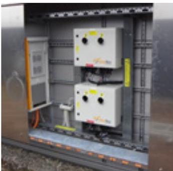
Ordnungstrennung für AC und DC-Leitungen sowie für geschützte und ungeschützte Leitungen
