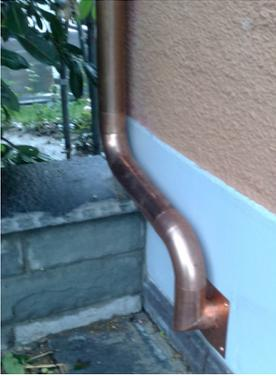
DC-Leitungen in Schutzrohr RF2 und in Cu-Fallrohr RF1 an Aussenfassade
