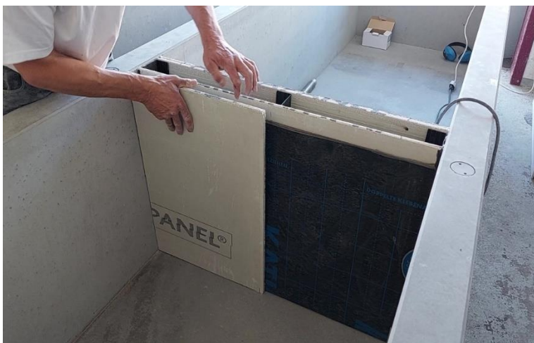
Abb. 9: Getestetes Abdichtungssystem bei Leichtbauwand
