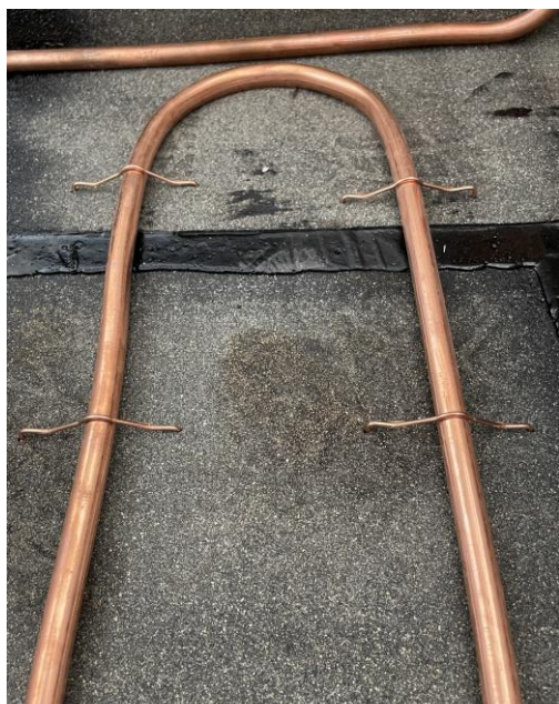
Abb. 3 und 4: Befestigung der Kupferrohre mit speziellen Klammern (Tacker aus Kupfer). Um die Ausdehnung nicht zu behindern, dürfen im Bogenbereich keine Klammern gesetzt werden.
