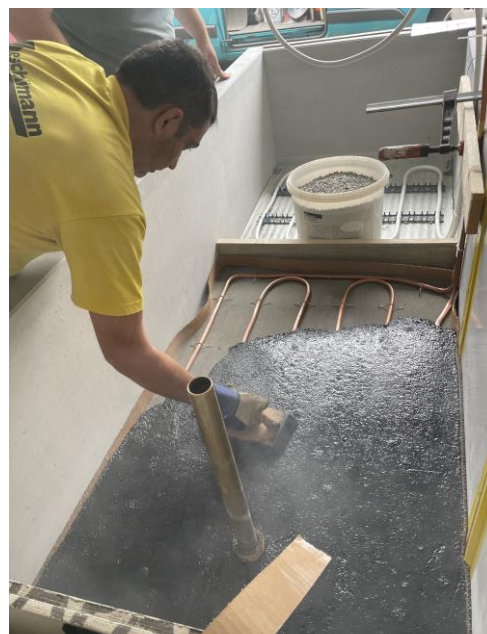
Abb. 3 und 4: Befestigung der Kupferrohre mit speziellen Klammern (Tacker aus Kupfer). Um die Ausdehnung nicht zu behindern, dürfen im Bogenbereich keine Klammern gesetzt werden.
