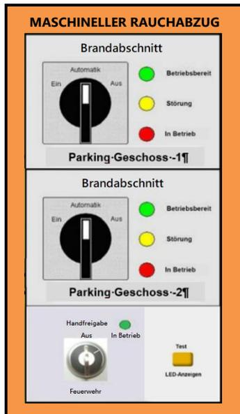
Gehäuse und Frontplatte orange, früher gelb mit Drehtüre, Glasfront und Drehgriff/Muschelgriff oder Bedienung offen mit Rahmen / Platte gelb, sowie Beschriftungen wie aufgezeigt
