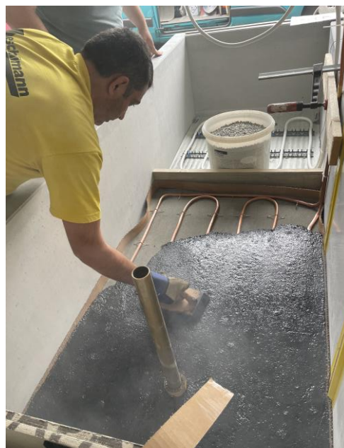
Abb. 2 und 3: Befestigung der Kupferrohre mit speziellen Klammern (Tacker aus Kupfer). Um die Ausdehnung nicht zu behindern, dürfen im Bogenbereich keine Klammern gesetzt werden.
