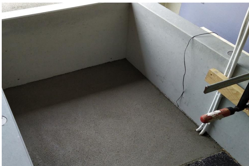
Abb. 6: Versuchsanordnung mit einem Zementestrich nach dem Ableitungsprinzip. Wird der Zementestrich nur geschliffen und nachbehandelt, ist nach einem Hochwasserereignis eine schadlose Austrocknung unter Mithilfe der Bodenheizung möglich.
