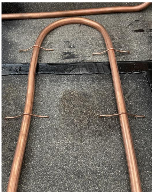
Abb. 2 und 3: Befestigung der Kupferrohre mit speziellen Klammern (Tacker aus Kupfer). Um die Ausdehnung nicht zu behindern, dürfen im Bogenbereich keine Klammern gesetzt werden.
