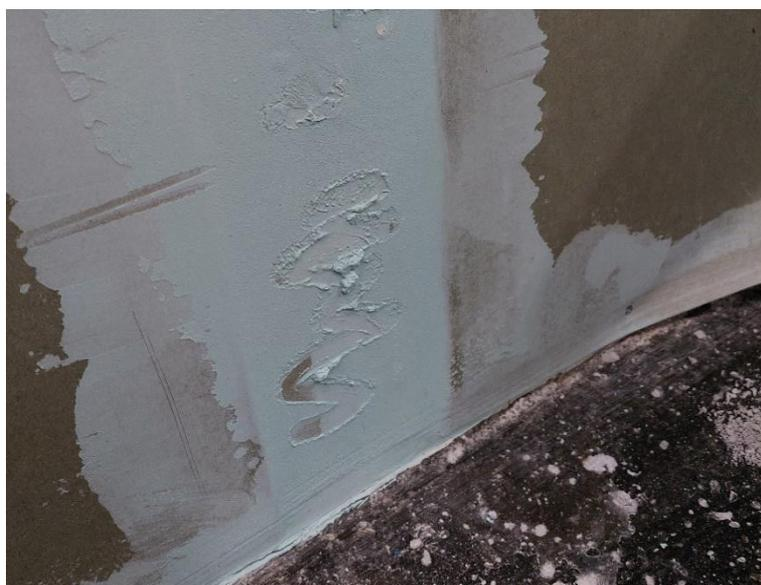
Abb. 9 Aufgeweichte Spachtelmasse bei Plattenstößen nach Wassereinstau
