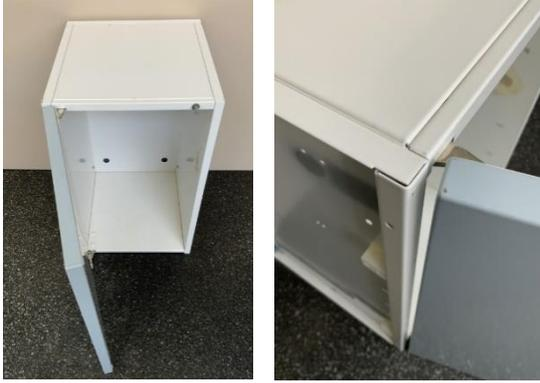
Die Forster-Stahlküche besteht aus massgekanteten Metallplatten. Diese werden zu Küchenelementen geformt und auf einem Metallsockel aufgestellt. Die Fronten werden aus Metall-Sandwiches mit einem Kartonwabenkern gefertigt. Dieser wird verklebt und ist dicht ausgeführt.
