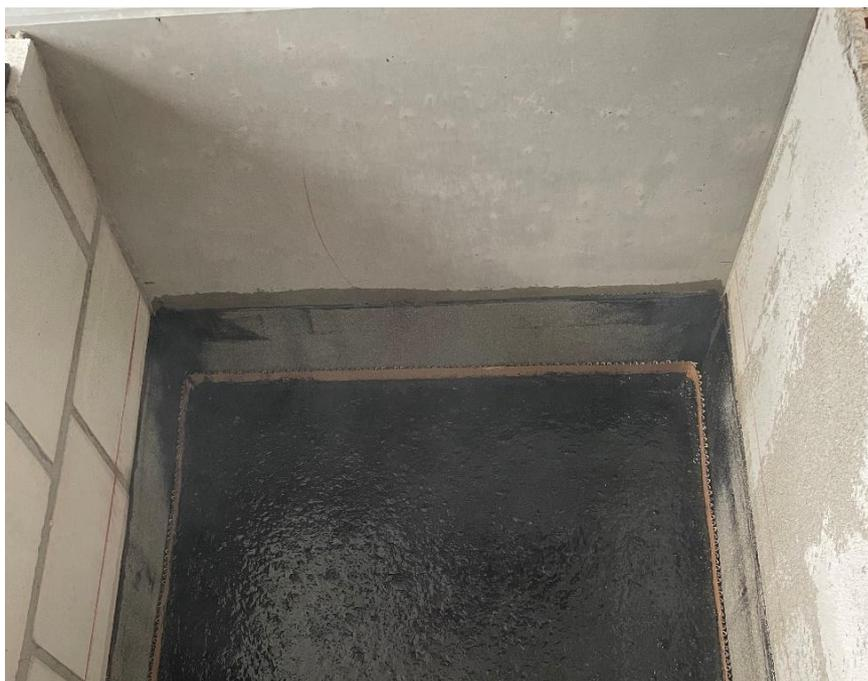
Abb. 4: Wasserdichter Anschluss durch eine Polymerbitumen-Dichtungsbahn (PBD) vor Einbau des Gussasphalts. Derartige Anschlüsse an unverputzte Mauerwerkswände (links) und auch speziell verputzte Mauerwerkswände sind allerdings hinterläufig bei Beanspruchungen mit drückendem Wasser (s. Kap. 4.2). Die oben offenen Randstellstreifen aus Wellkarton trocknen innert nützlicher Frist schadlos aus.
