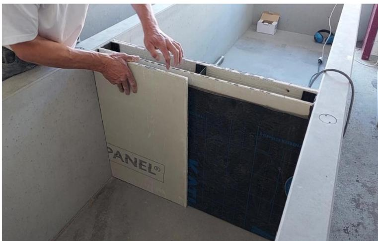
Abb. 7: Getestetes Abdichtungssystem bei Leichtbauwand
