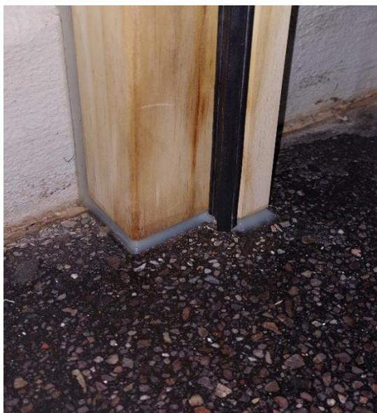
Abb. 10: Verfärbter, jedoch intakter Türrahmen aus Accoya nach Wassereinstau.
