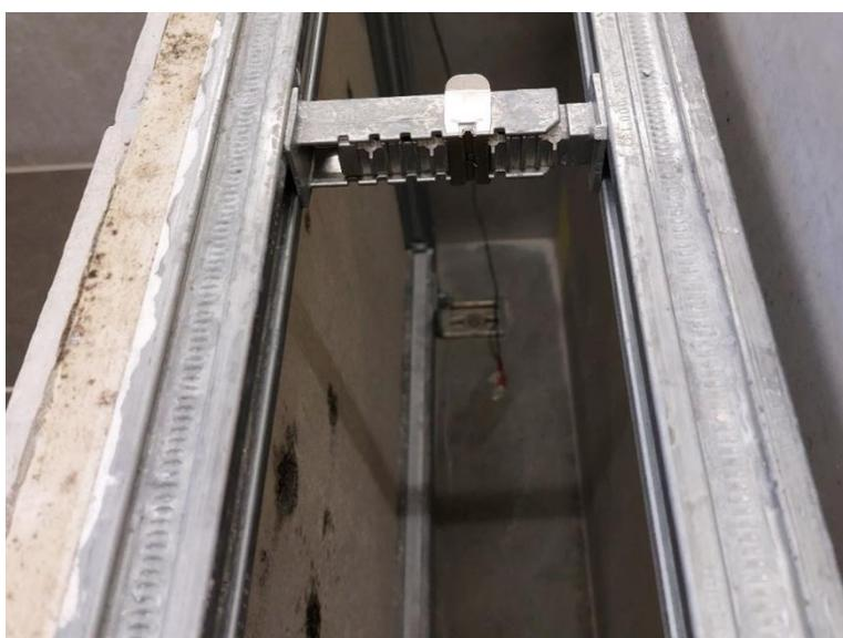
Abb. 8: Vereinzelter Schimmelpilzbefall auf Aquapanelplatten bei Vorwandinstallation GIS
